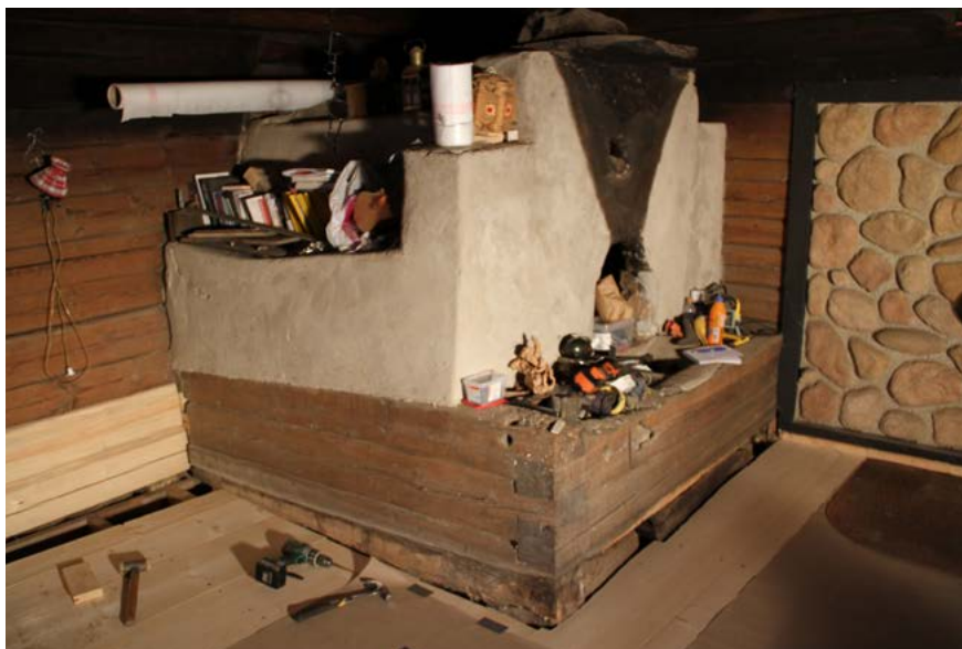
Røykovnen og et nylagt gulv, foto: Hans Johnsson
