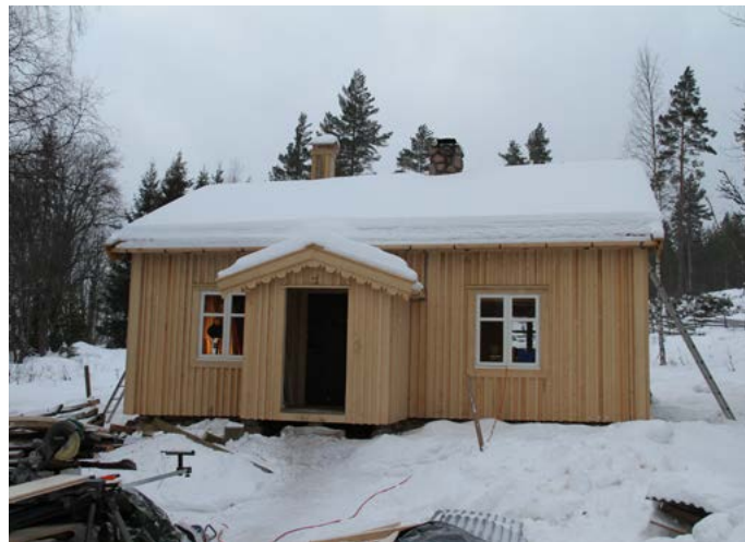
Røykstua med nytt utvendig panel og ny røykhatt, foto: Hans Johnsson
